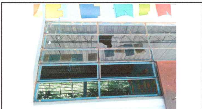
Foto 3. Sustitucion de vidrios
