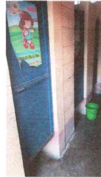
Foto 16: Fabricación e Instalación de puerta de metal individual en BAÑO
