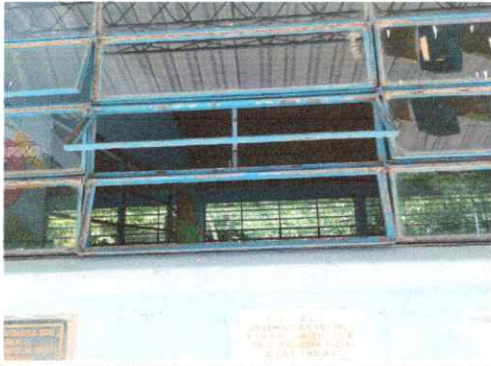
Foto 13: Fabricación e instalación de balcones de hierro en ventana
