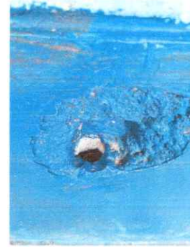
Foto 10: Sustrucción de llave de paso
