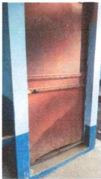
Foto 15: Fabricación e Instalación de puerta de metal PRINCIPAL en BAÑOS
