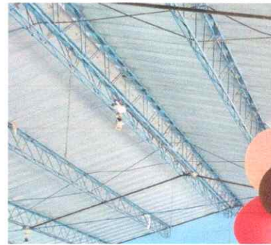
Foto 12: Sustrucción de focos ahorradores
