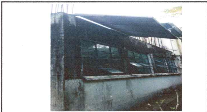
Foto 1: Sustitucion de lamina troquelada por lamina troquelada Aluzinc calibre 26 AULA
