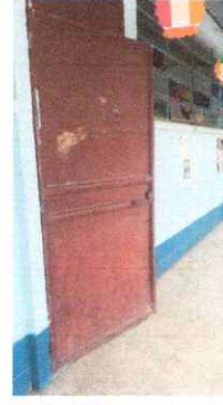
Foto 14: Fabricación e Instalación de puerta de metal en AULA
