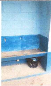
Foto 7: Sustrucción de mezcladora lavamanos (contra llave, tubo de abasto, Conectores)
