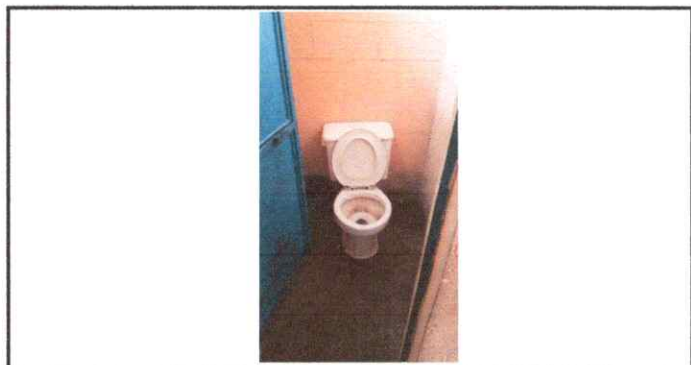
Foto 6. Sustitución de inodoro
