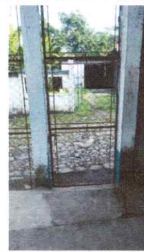
Foto 18: Fabricación e Instalación de puerta de metal de ingreso
