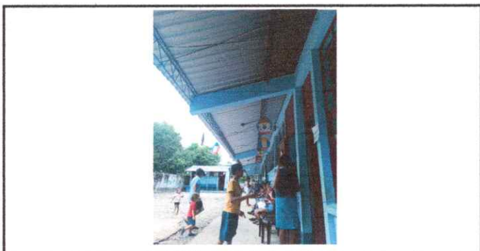
Foto 5. Sustitución de bajada de agua pluvial de metal por tubo PVC 3" AULAS. Sustitución de soporte o pescante de metal para canal AULAS
